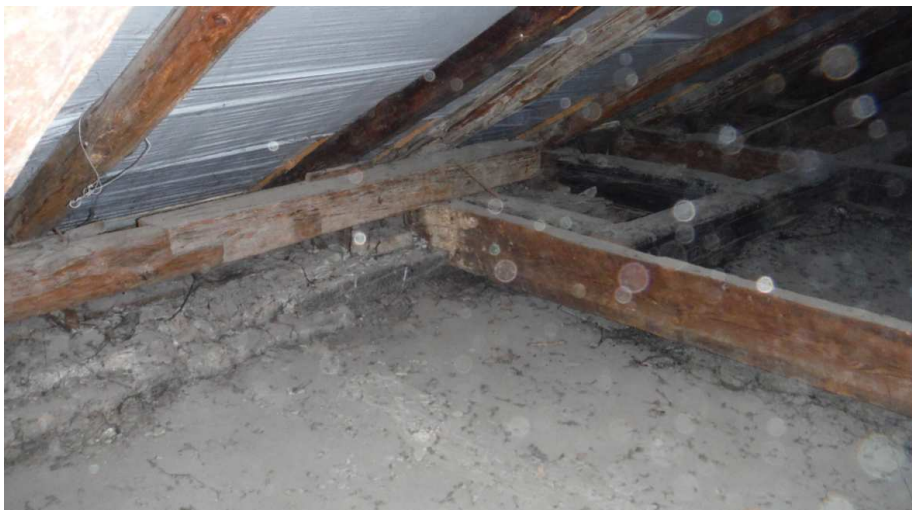
9.sz kép szerkezeti váltás fiókgerenda – talpszelemen kialakításra
