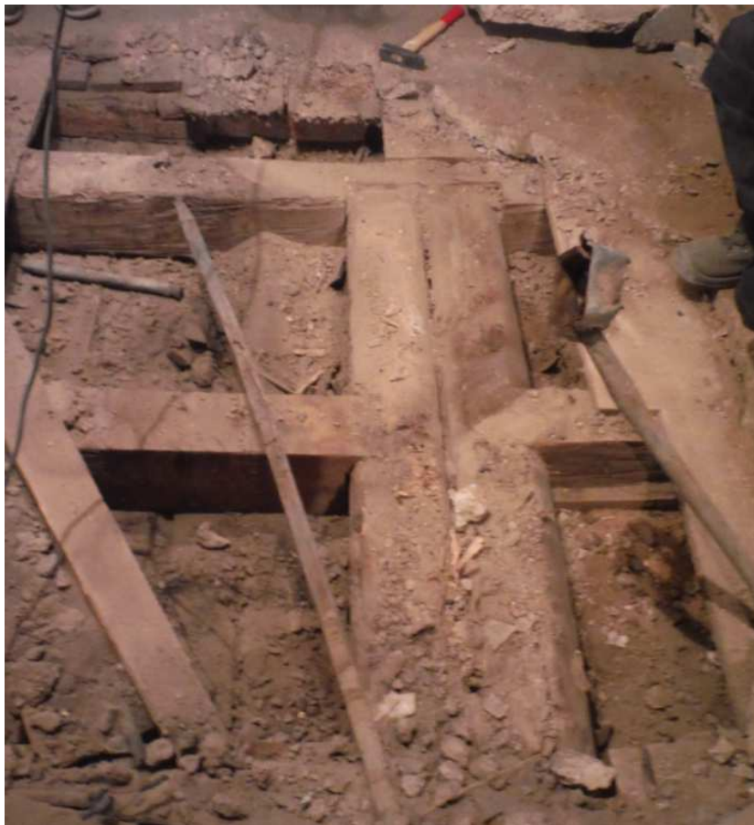
5.sz kép Meghajlott födémrész feltárása, kettőzött fióktartó kialakítással
