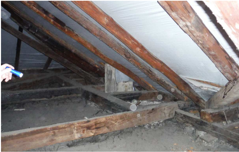
8.sz kép szerkezeti váltás helye/ kettős állószékes – állószékes fedélszékre
